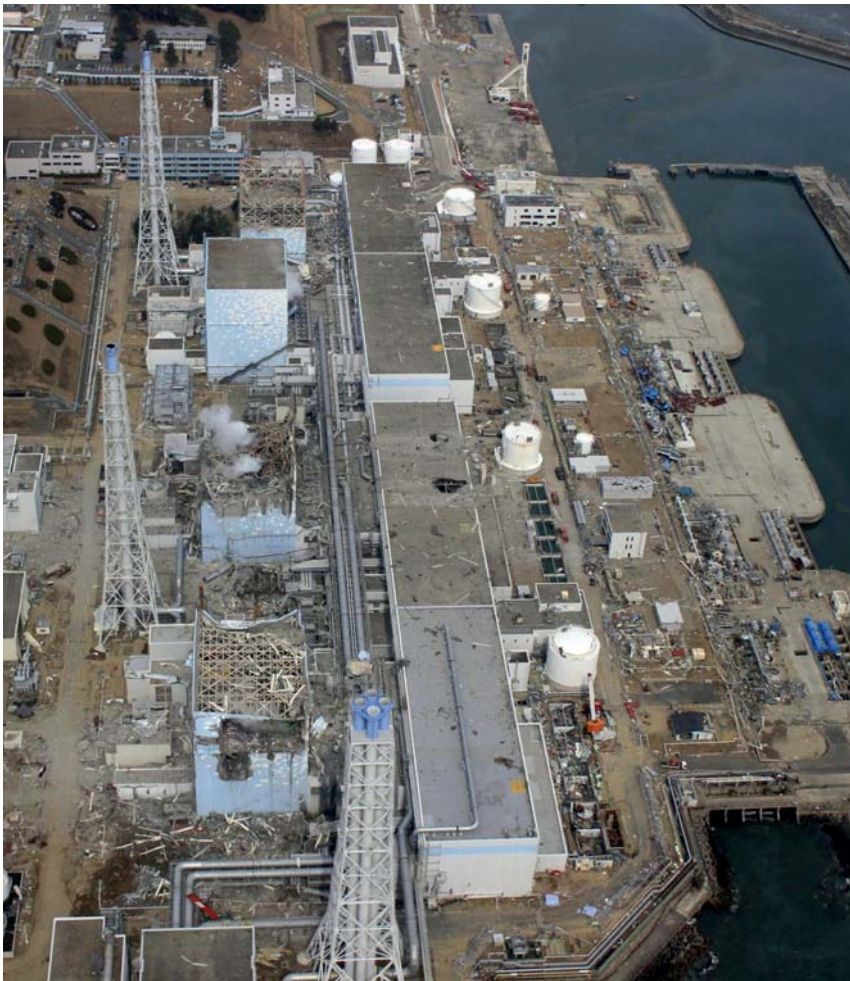
Consecuencias del accidente de Fukushima Daiichi el 18 de marzo de 2011, una semana después de producirse. Por toda la zona aparecen escombros de las explosiones de hidrógeno que tuvieron lugar en las unidades 1, 3 y 4. A lo largo de la línea costera se aprecian los desperfectos causados por el terremoto y el tsunami en los sistemas eléctricos. Aún emana vapor de la unidad 2.
