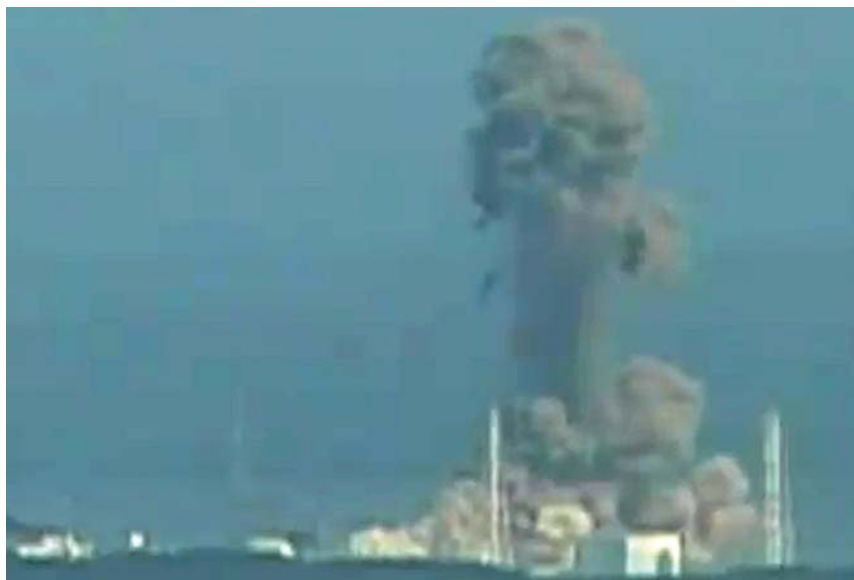
La explosión de gran intensidad que expulsó en vertical hidrógeno o posiblemente vapor en el BWR de la unidad 3 de Fukushima Daiichi el 14 de marzo de 2011 fue seguida de un incendio y de posibles daños en el combustible del reactor. En la fotografía se observa cómo se proyectan verticalmente y después caen escombros pesados, entre los que posiblemente se encuentren la tapa del blindaje de hormigón o fragmentos de la grúa. No se puede inferir la existencia de daños en la vasija de presión del reactor debido a la ausencia de la tapa superior de éste entre el material eyectado. Fuente: NTV / NNN Japón.
