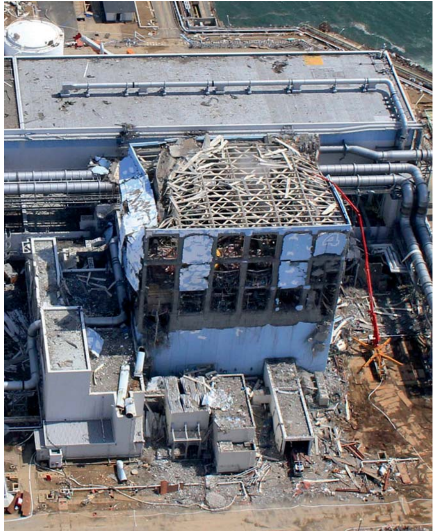
Imagen aérea de la unidad 4 de la planta nuclear, inoperativa en el momento del terremoto, que sufrió un incendio y una explosión.
